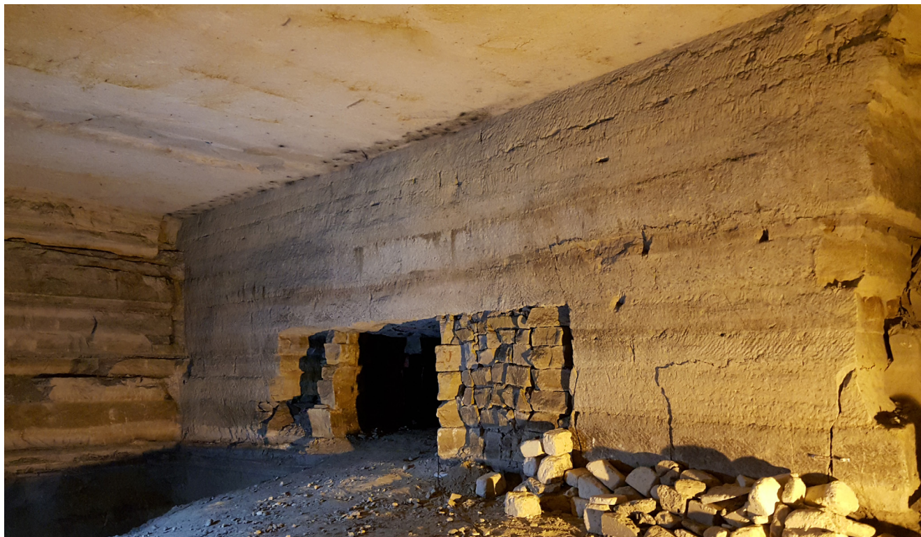
Fig. 2. — La carrière souterraine sous le bois de Vincennes, dite de la Brasserie, exploitée par piliers tournés. Dans le fond de taille, l'entrée de galerie d'une exploitation par haques et bourrages mesure deux mètres de hauteur (12 e arrondissement de Paris). Crédit photo : J.-P. Gély.
