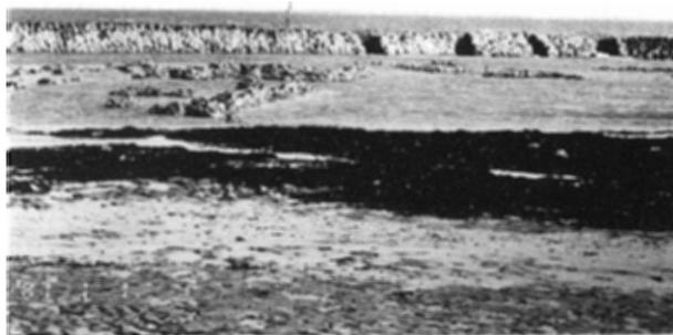
**Fig. 11 :** Saint Denis d'Oléron, écluse du Boyard, à marée basse ; on voit les ouvertures sur le large, les bouchots, au nombre de 4 ; à leur gauche, sur le bras, une perche de 3 m, obligatoire, signale aux bateaux la présence de l'écluse, qui disparaîtra entièrement sous l'eau à marée haute. A l'intérieur de l'écluse dans la foue, on aperçoit des bancs d'huîtres (captage à plat, directement sur pierre). (photo N. Desse-Berset).
